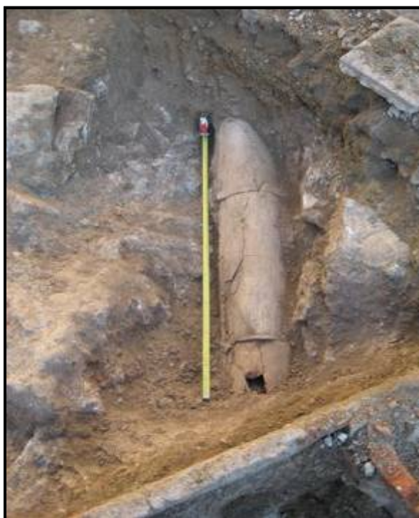
Foto 12: sondeig 1, detall de la canalització 1015 , retall de la roca 1014 , vist des del est
