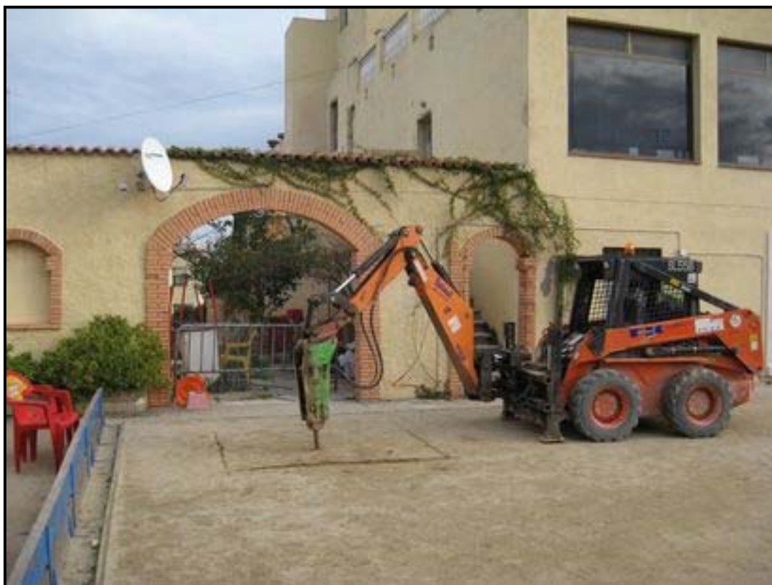
Foto 26 sondeig 4, rajoles de formigó, vist des del sud
