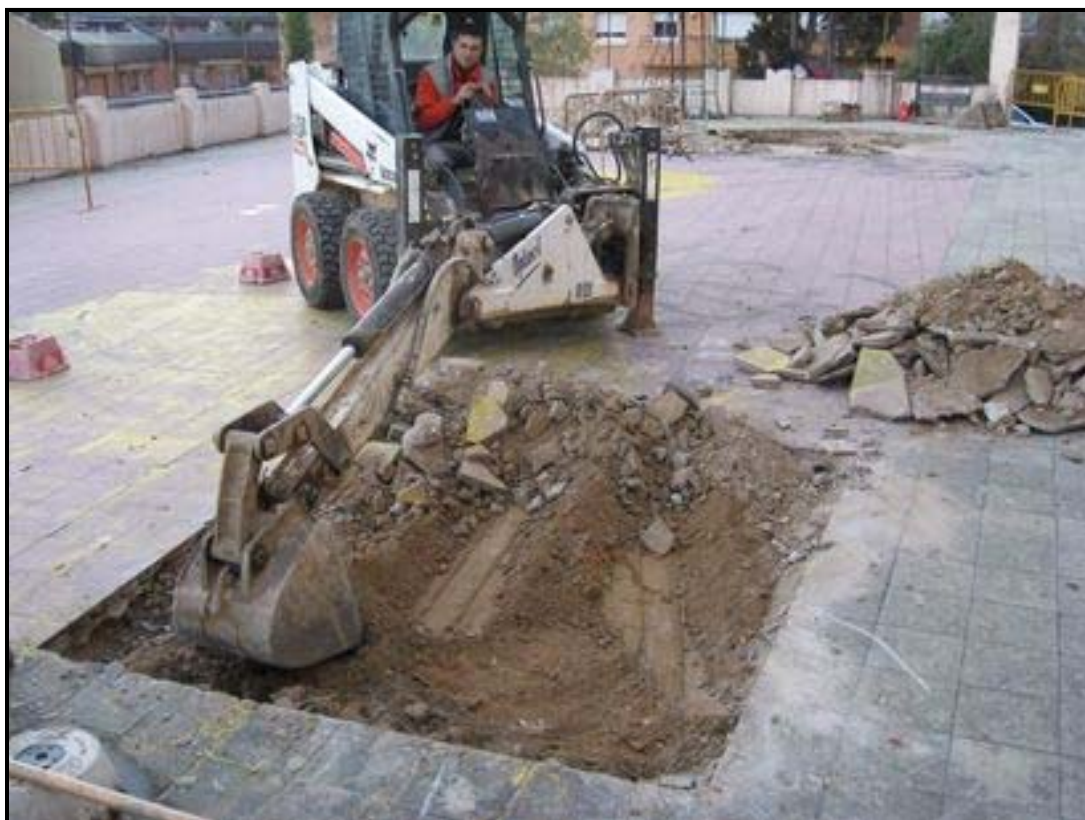
Foto 15: sondeig 2, rajoles de formigó, vist des del nord
