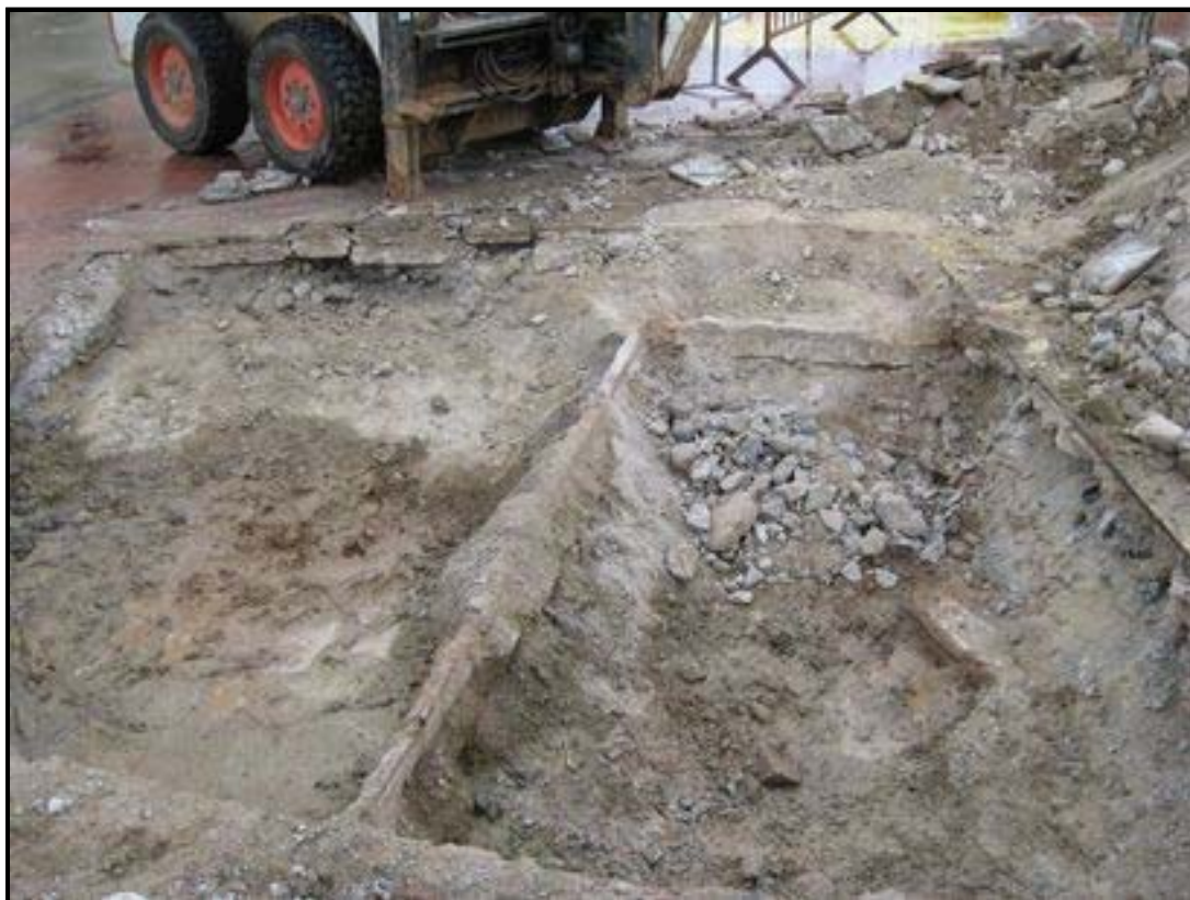
Foto 3: sondeig 1, mur UE 1003 , 1004 , 1008 , vist des del sud
