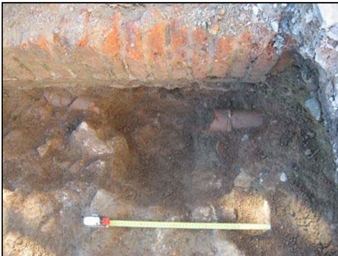
Foto 7 : sondeig 1, mur UE 1003, UE 1018 i tuberia 1017
