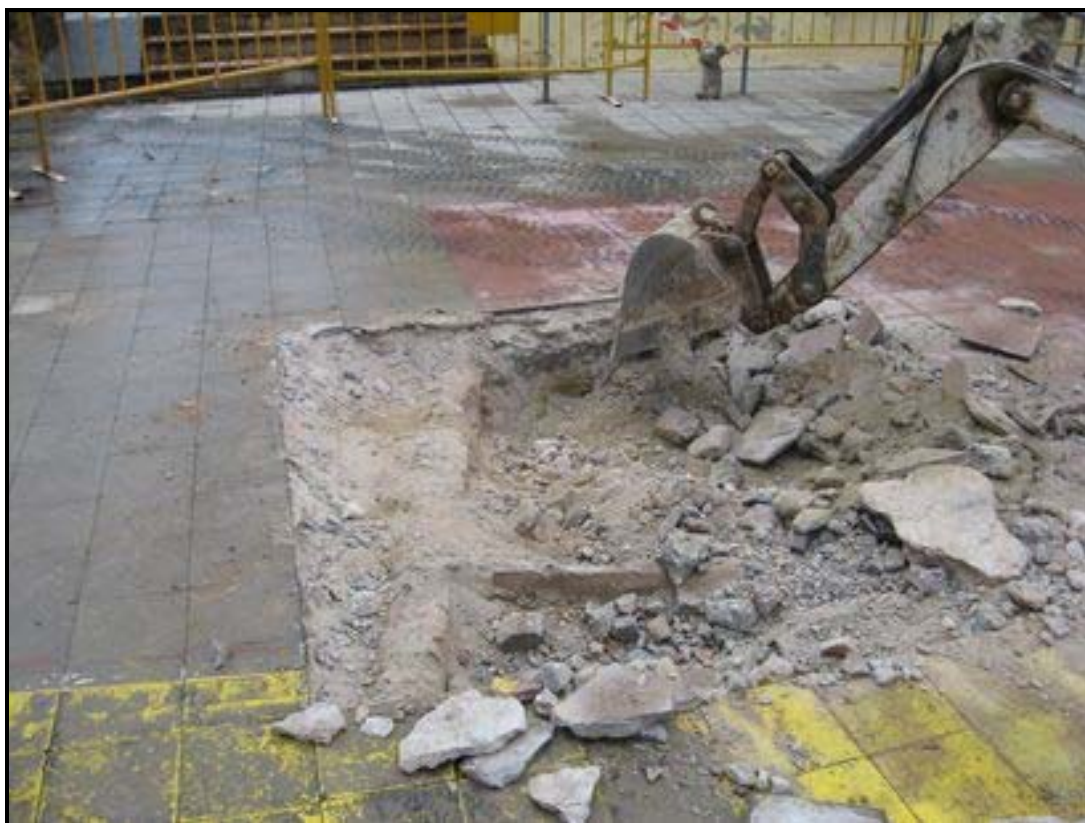
Foto 2 : Sondeig 1, mur UE 1003 i 1004 , vist des del est
