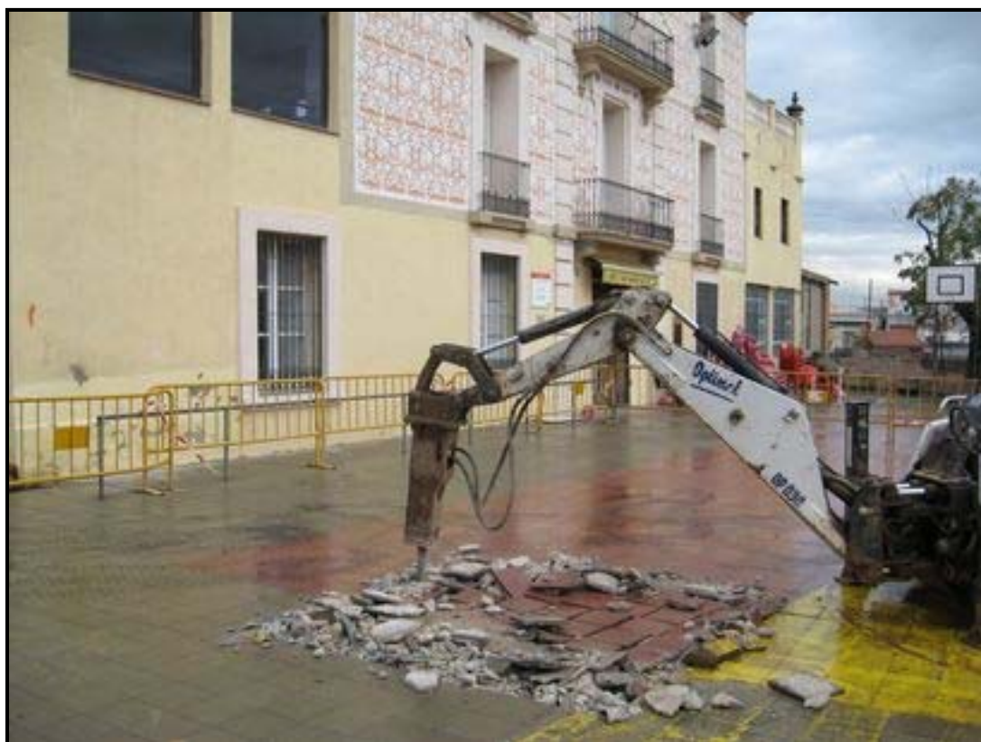
Foto 1: Sondeig 1, rajoles de formigó, vist des del sud
