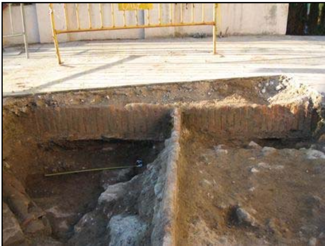
Foto 9 : sondeig 1, mur UE 1003,1004 , tuberia 1017 , canalització 1015
