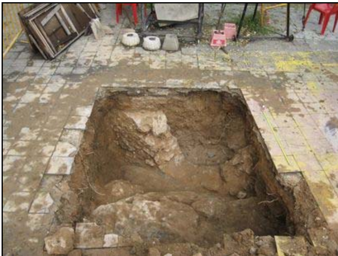
Foto 20 : sondeig 2, mur 2008 , roca mare 2007 vist des del sud
